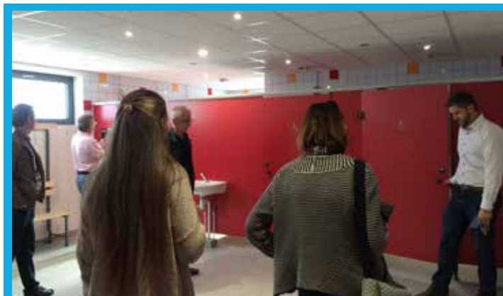
Nouveaux vestiaires du petit gymnase
