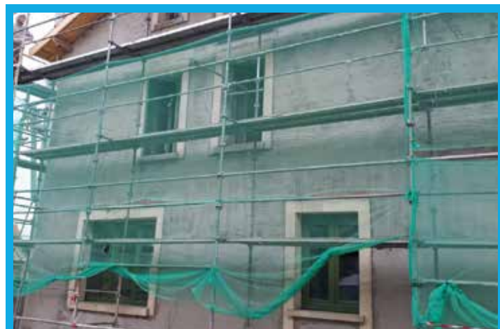
Travaux extérieurs Commerce de Damvillers
