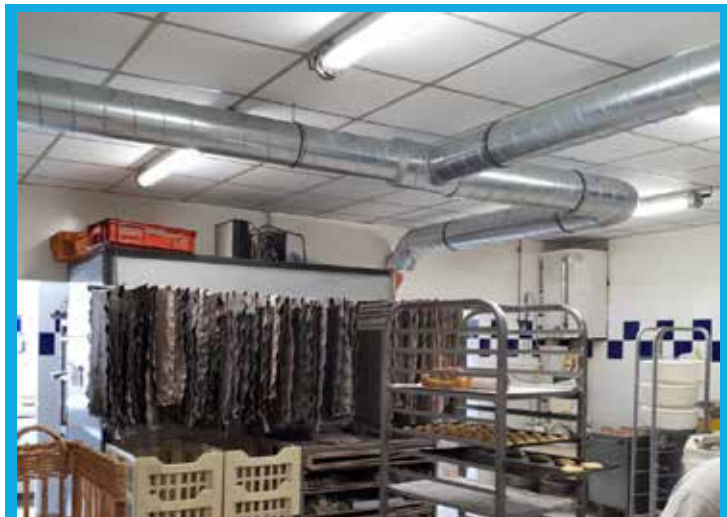
Boulangerie de Billy Sous Mangiennes après travaux
