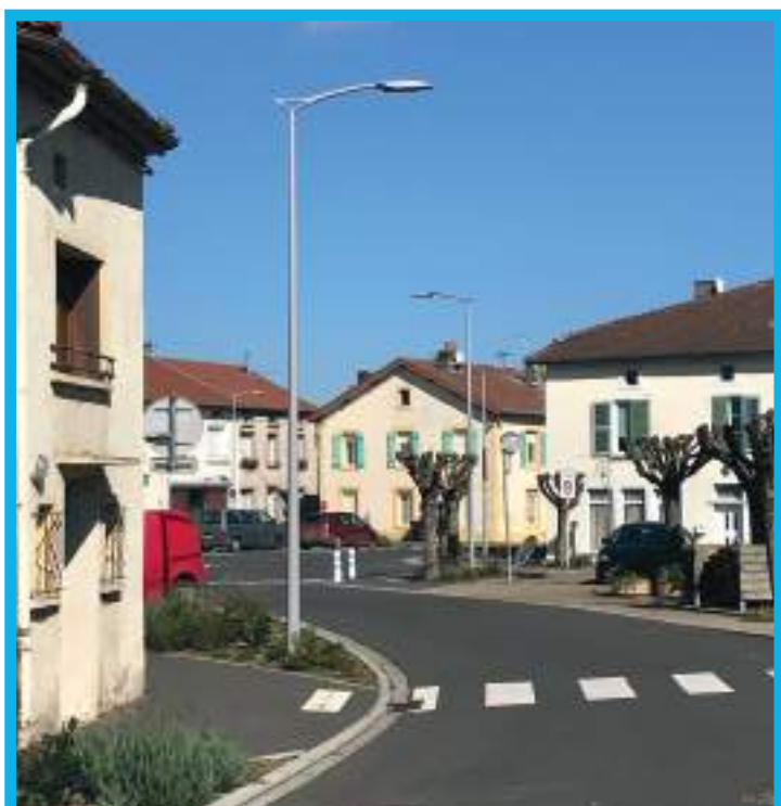
Damvillers - Nouveaux points lumineux centre bourg
