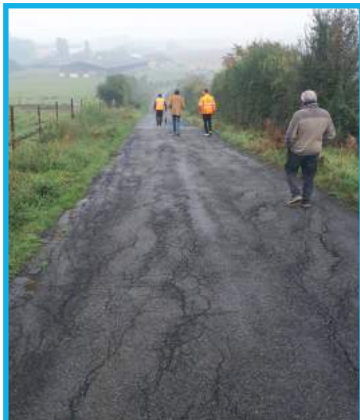
Route Delut-Dombras : pictage avant travaux
