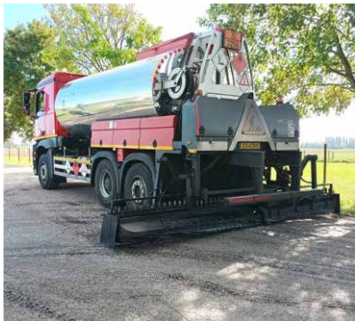
Enduit bicouche route d'Eton - Senon
