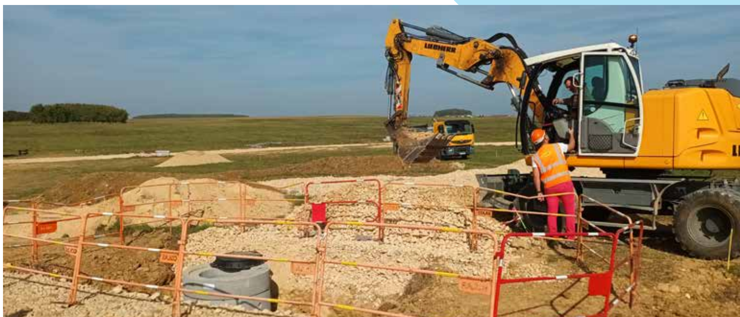
Début des travaux de viabilisation
