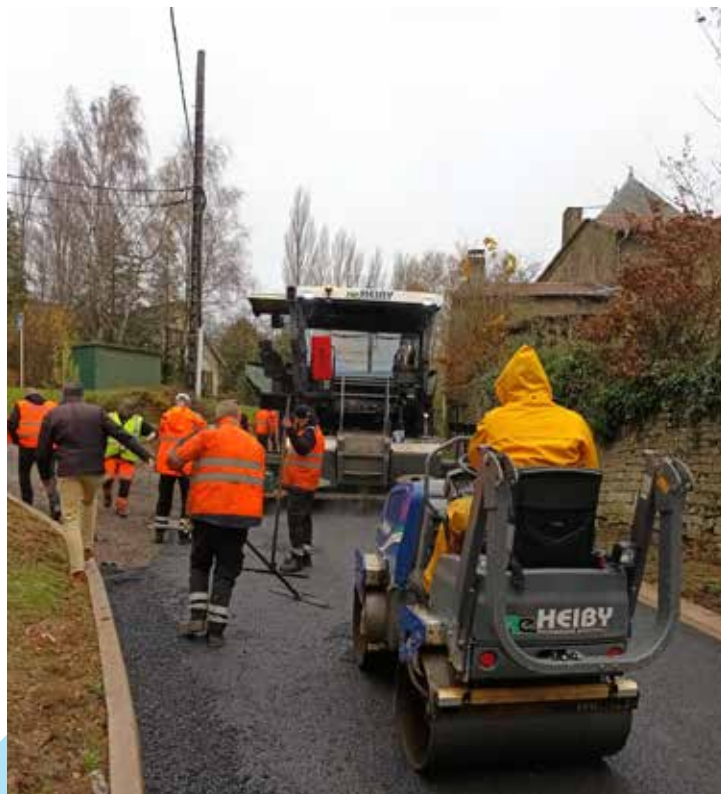
Pose d'enrobé à Arrancy-sur-Crusnes
