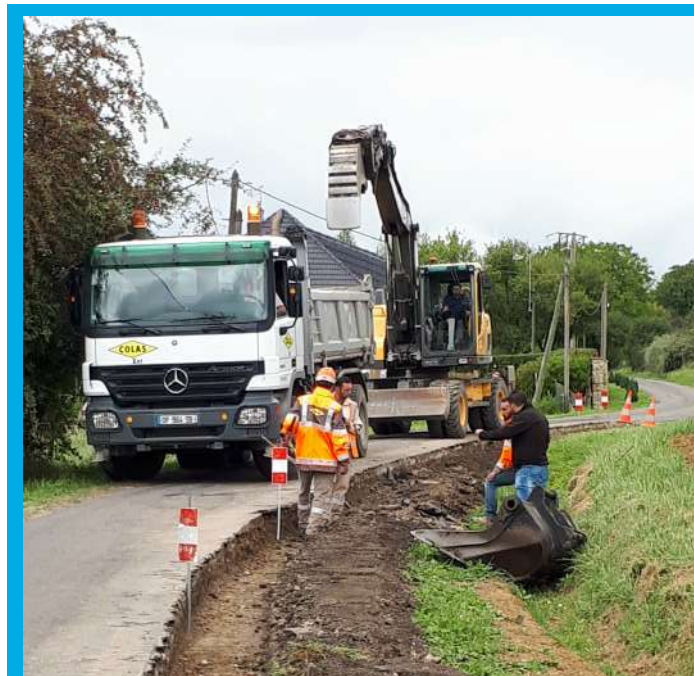
Travaux voie Spincourt Houdelaucourt
