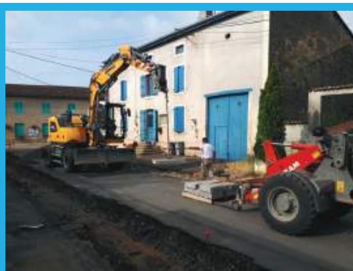
Travaux sur la Commune de Billy Sous Mangiennes
