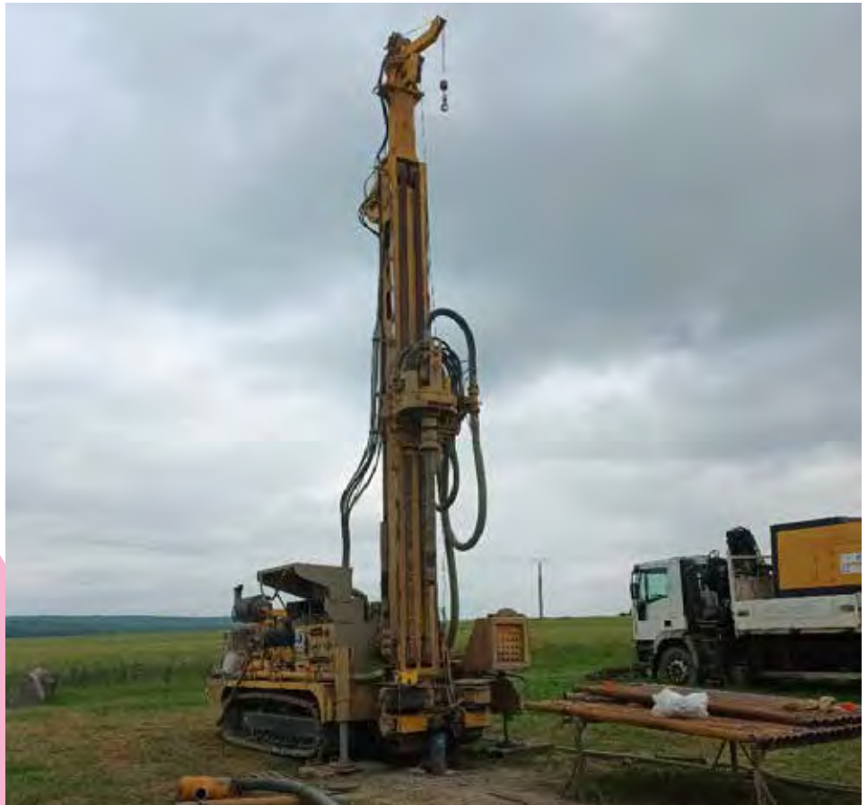
Forage des sondes verticales
