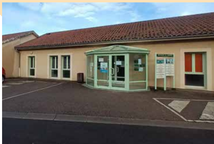
Maison de Santé de Damvillers
