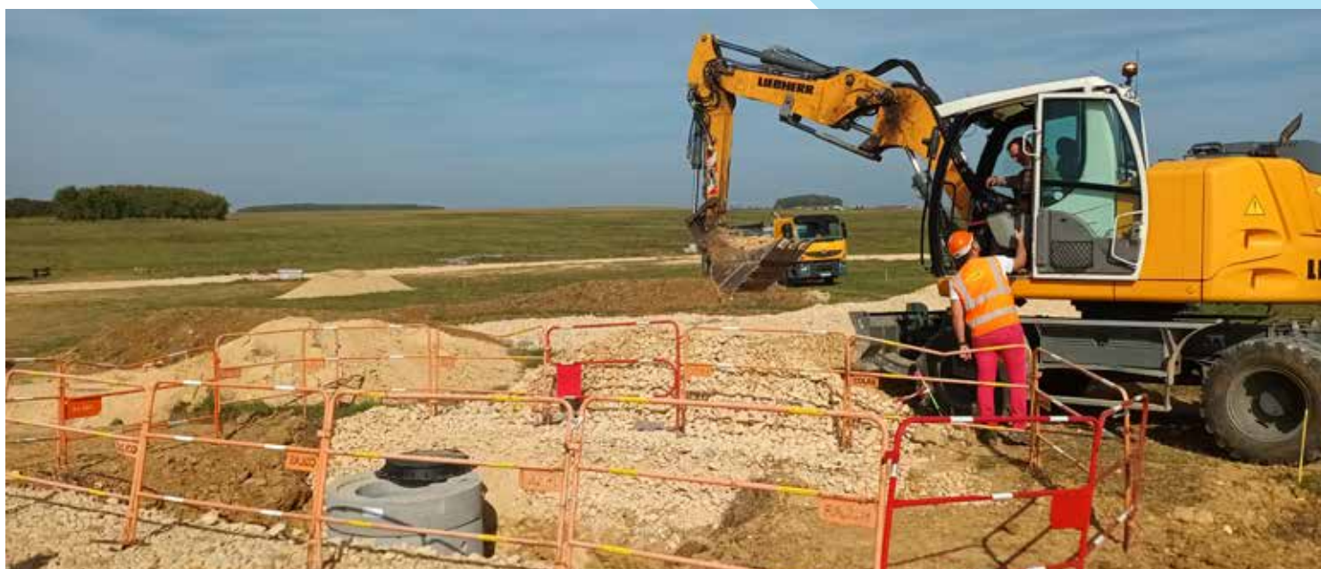
Début des travaux de viabilisation
