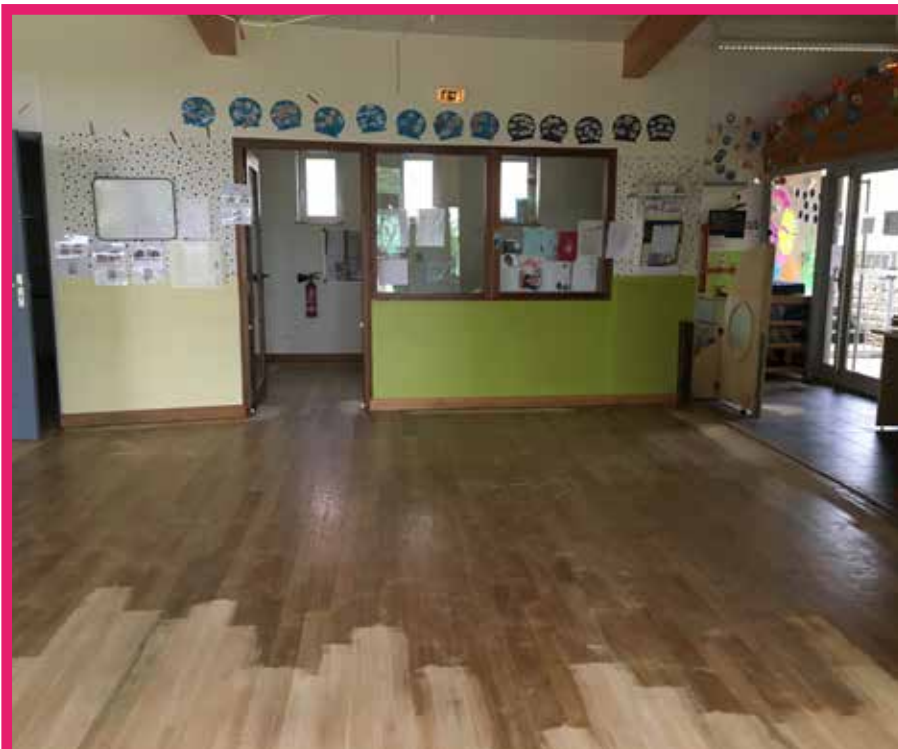
Ponçage du parquet
