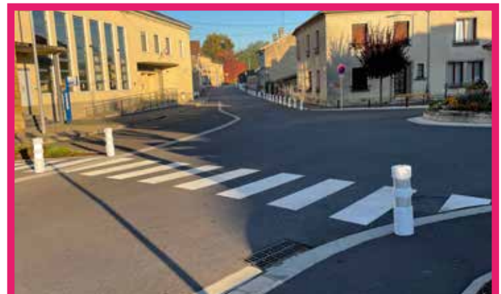
Abords de l'école de Damvillers
