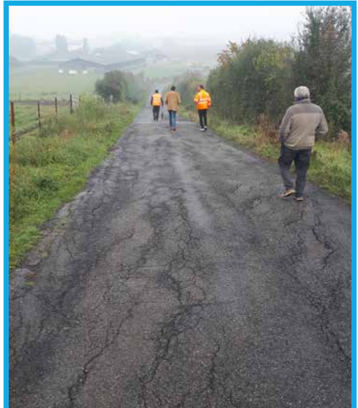
Route Delut-Dombras : pictage avant travaux
