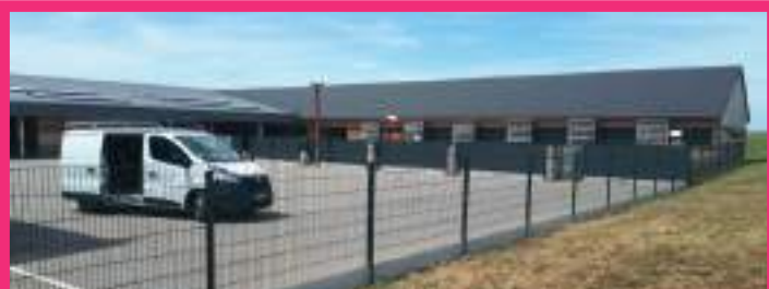
Nouvelle clôture au groupe scolaire de Dommary-Baroncourt, pour un montant de 11 371€ HT
