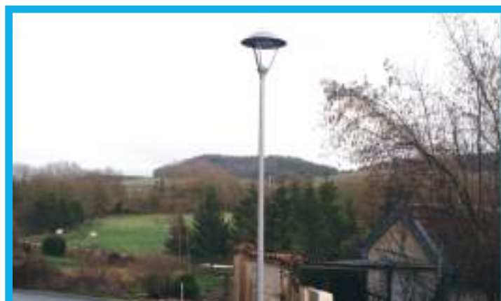
Nouveau point lumineux LED rue des remparts à Damvillers
