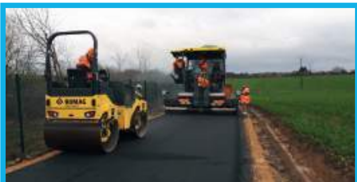
Travaux route menant à GDE et WIG France.
