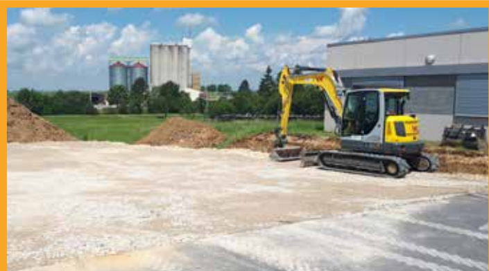
Santé : Travaux d'extension de la Maison de Santé à Spincourt
