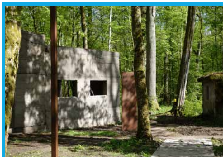
Vue d'un bâtiment nettoyé et consolidé
