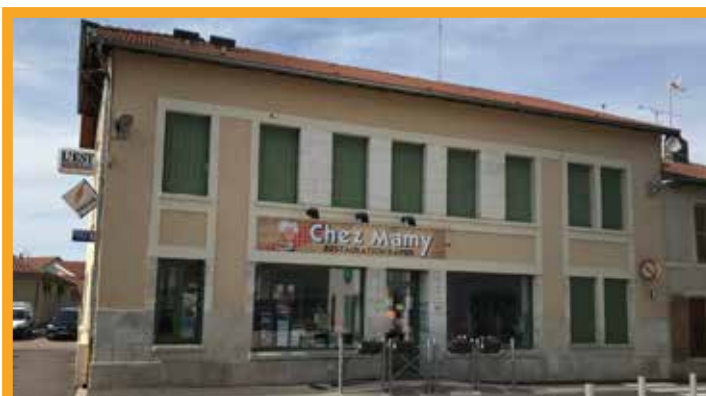
Habitat : rénovation de logements intercommunaux à Damvillers
