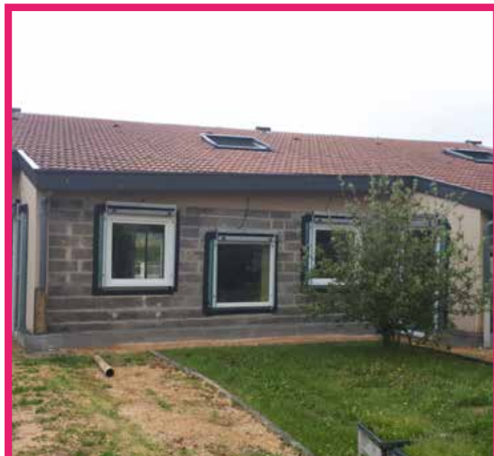
Ecole de Rouvrois - Nouvelles fenêtres
