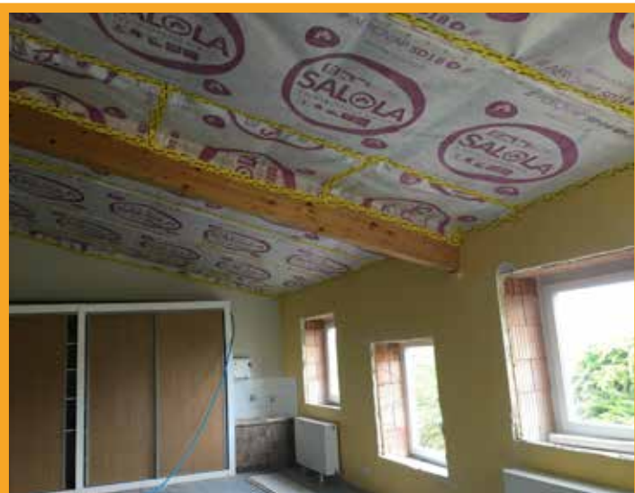
Scolaire : Rénovation thermique de l'école de Rouvrois
