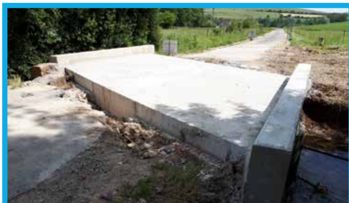
Reprise du tablier du pont à Flabas
